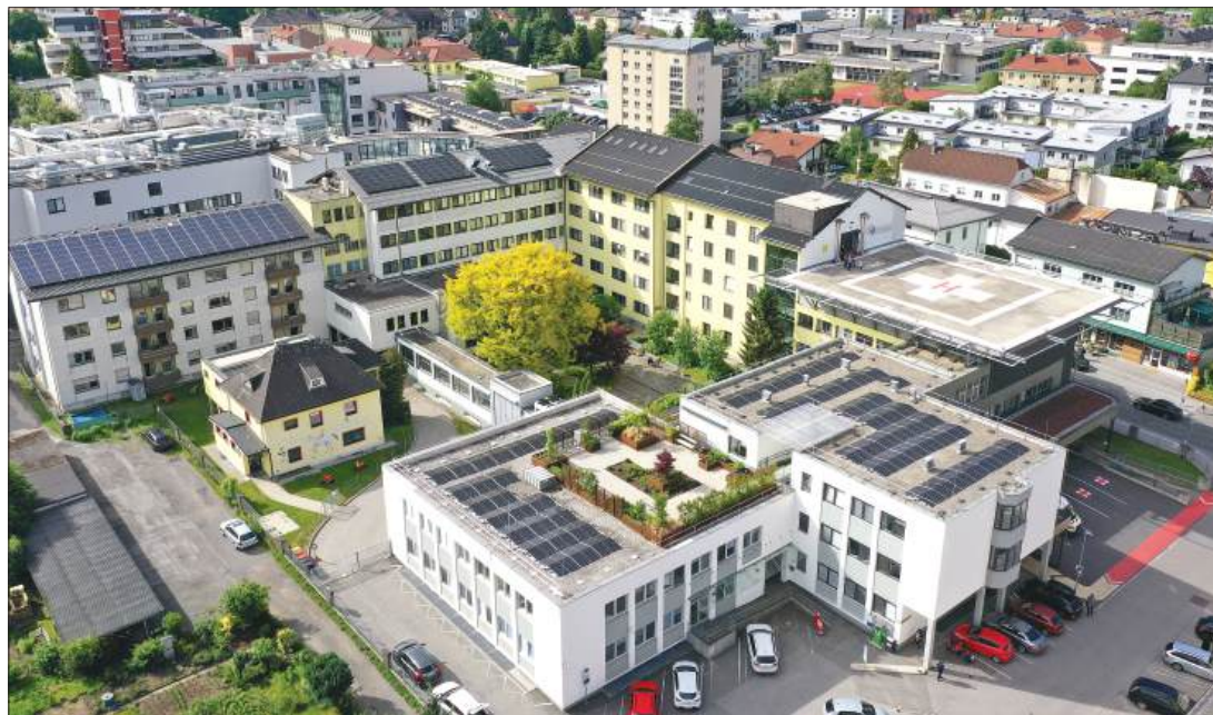
PV-Anlagen, begrünte Dächer und moderne Haustechnik helfen dem Krankenhaus Spittal, Energie zu sparen.
